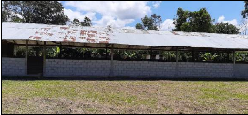
Imagen N.- 31 Asentamiento Sumino Izquierdo
